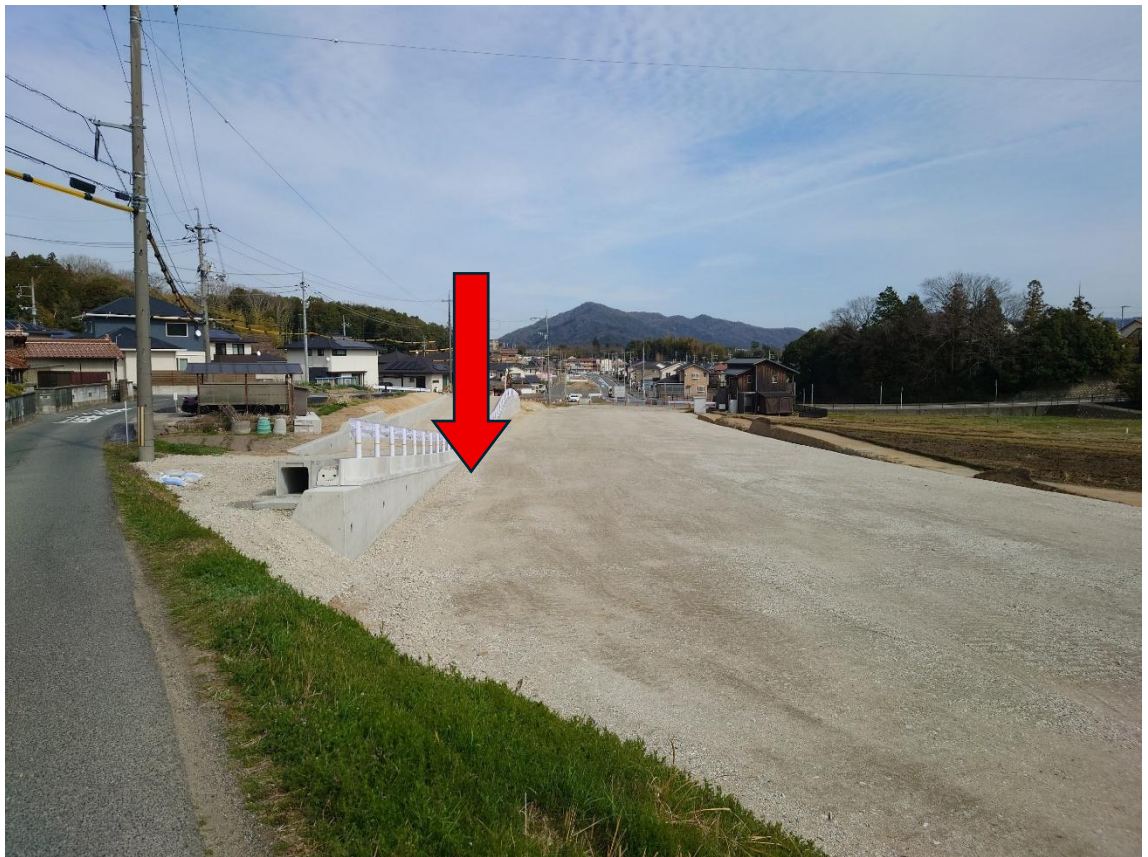
プレハブ設置箇所 (矢印で示した箇所)
