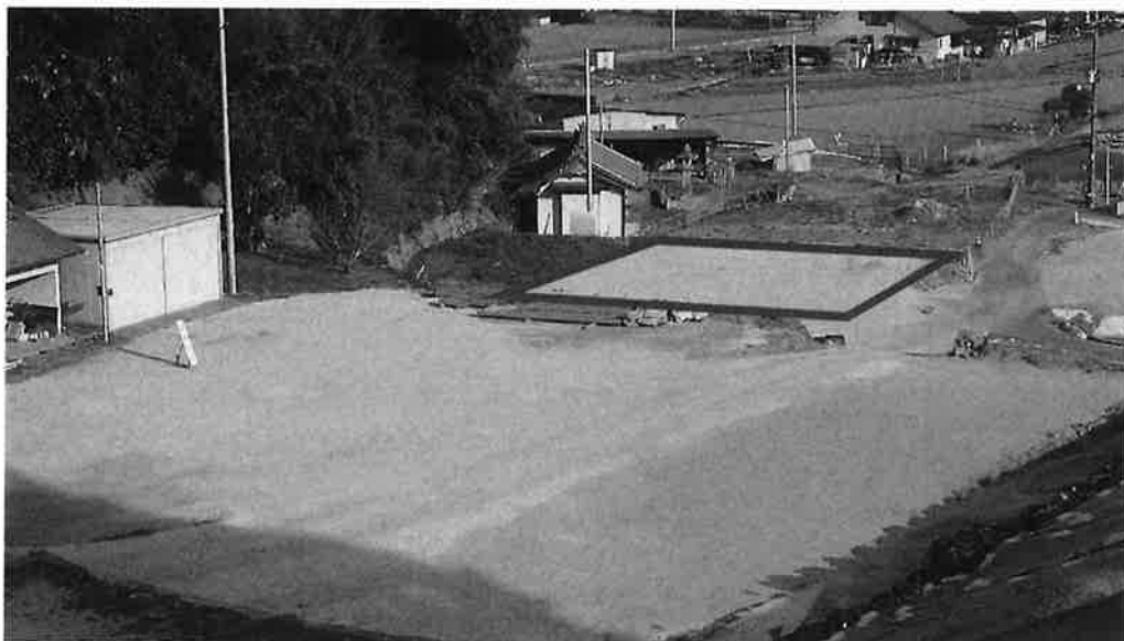
赤枿がプレハブ建設予定地
