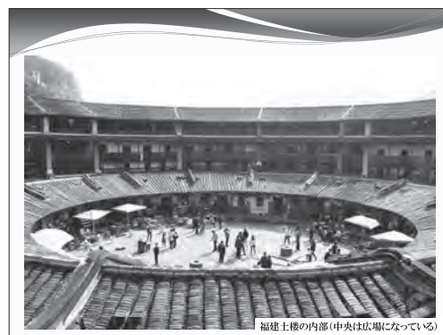
【スライド20】 中国・福建土楼の内部
