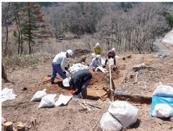
作業風景 (北東から)
