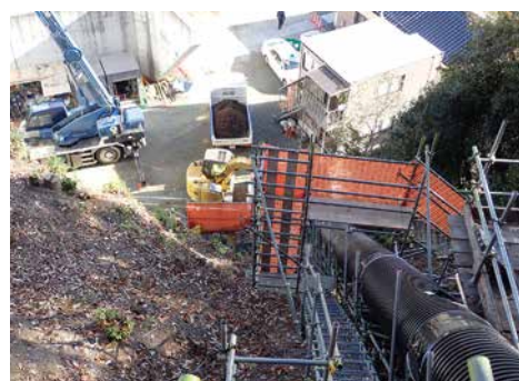
排土の搬出作業
