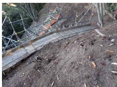
東側調査区調査前（北西から）
