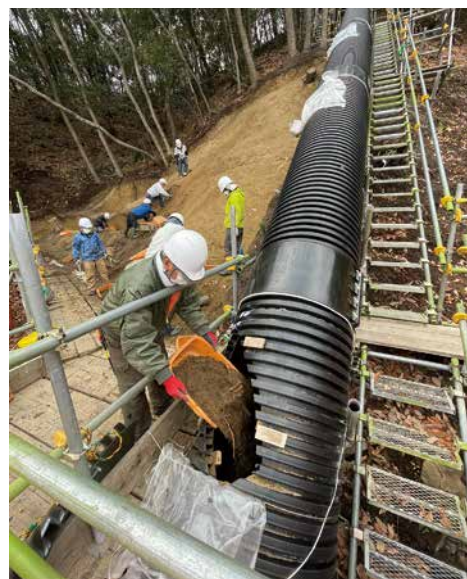
排土作業のようす
