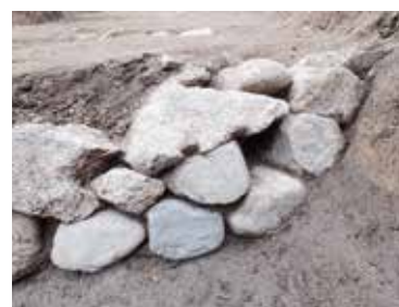
水田の石積みにある矢穴（南西から）
