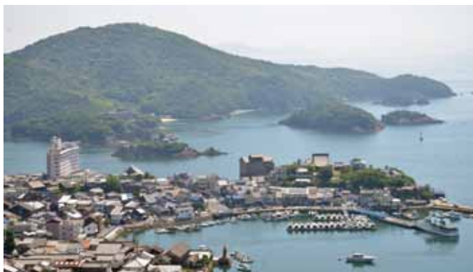
雁木全景（南西から）
