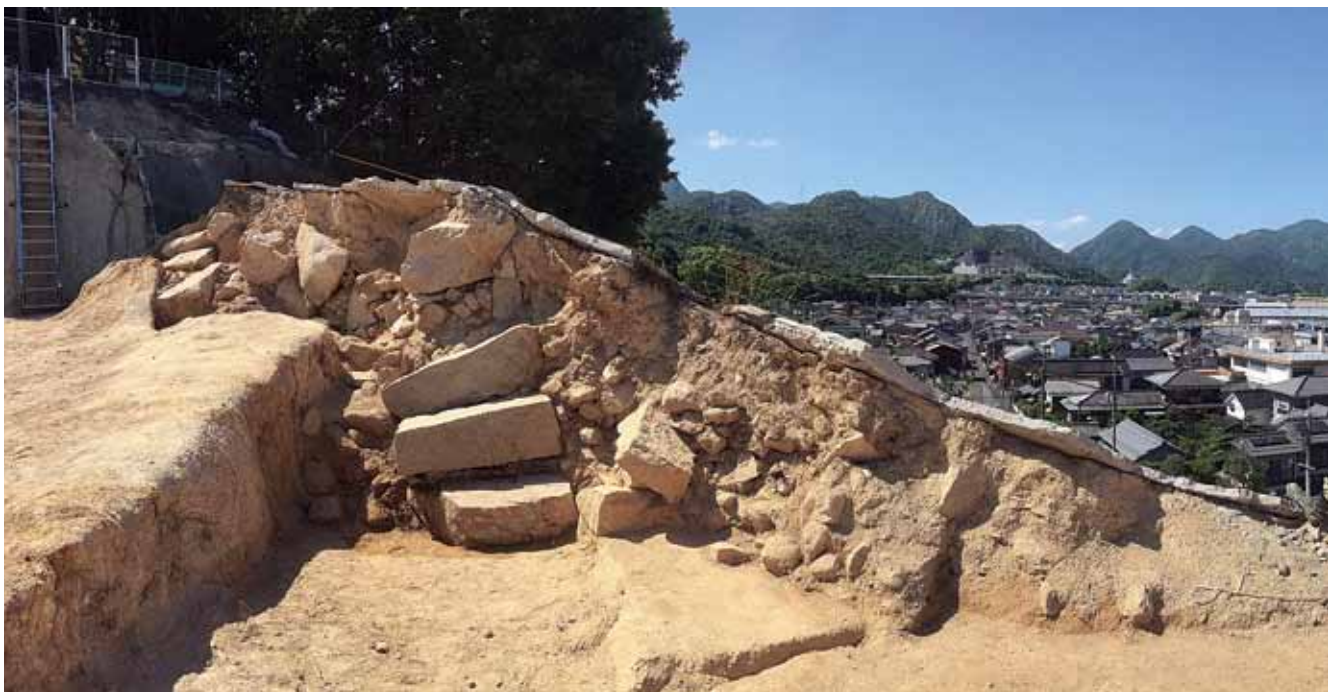
石垣の裏込めと前面の砂礫 (破城行為によって石が転落している)
