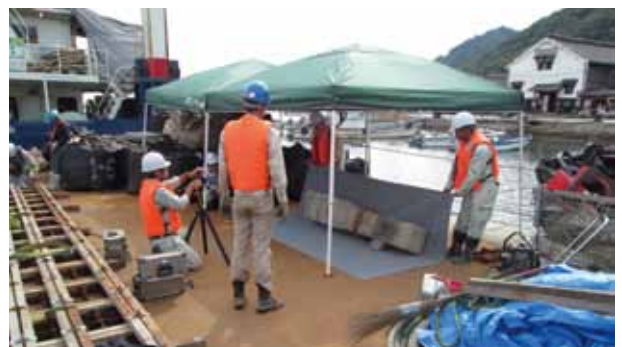
繫船柱の調査
