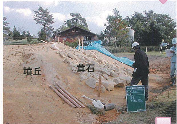
2 葺石の復元作業 (23.11.14)
