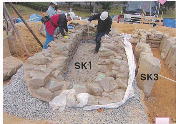
3 石室(SK1)の据えつけ作業 (23.11.25)
